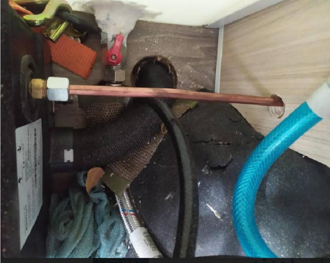
Unión de la tubería al element (cocina, boiler,..)
